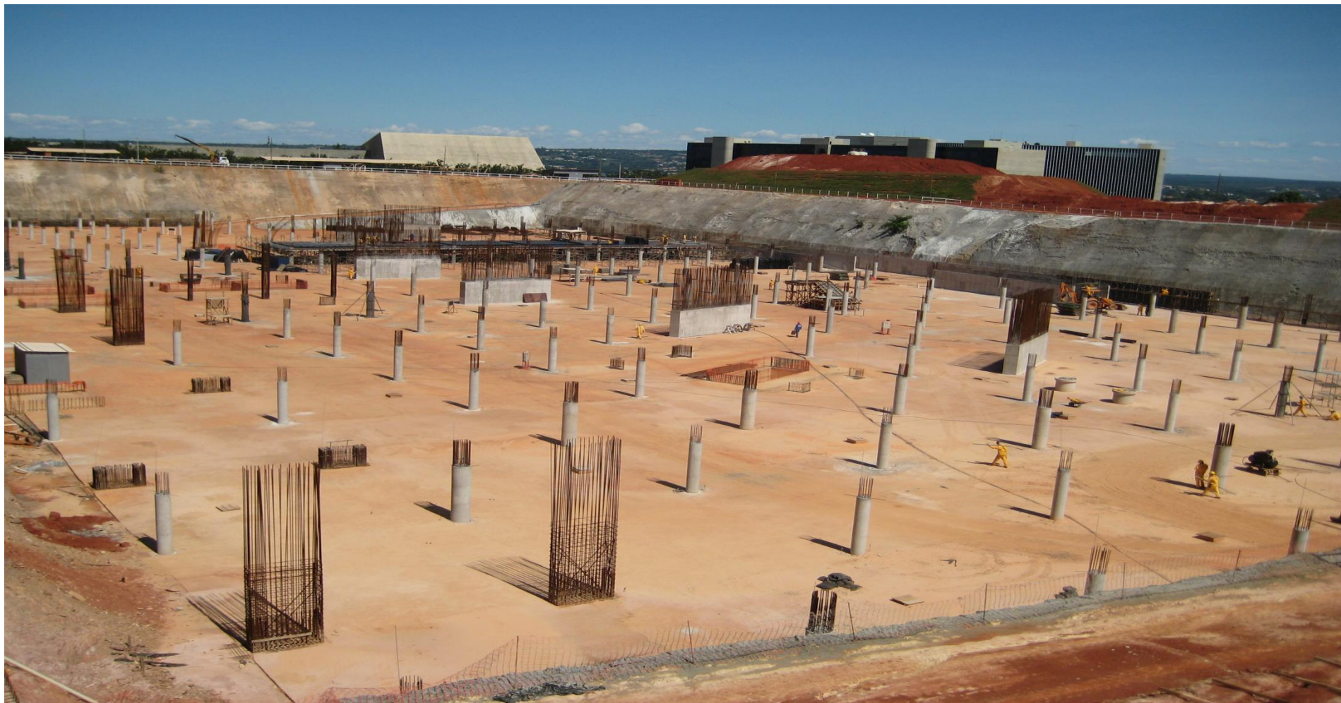
Foto 1 – Vista Geral da Obra
