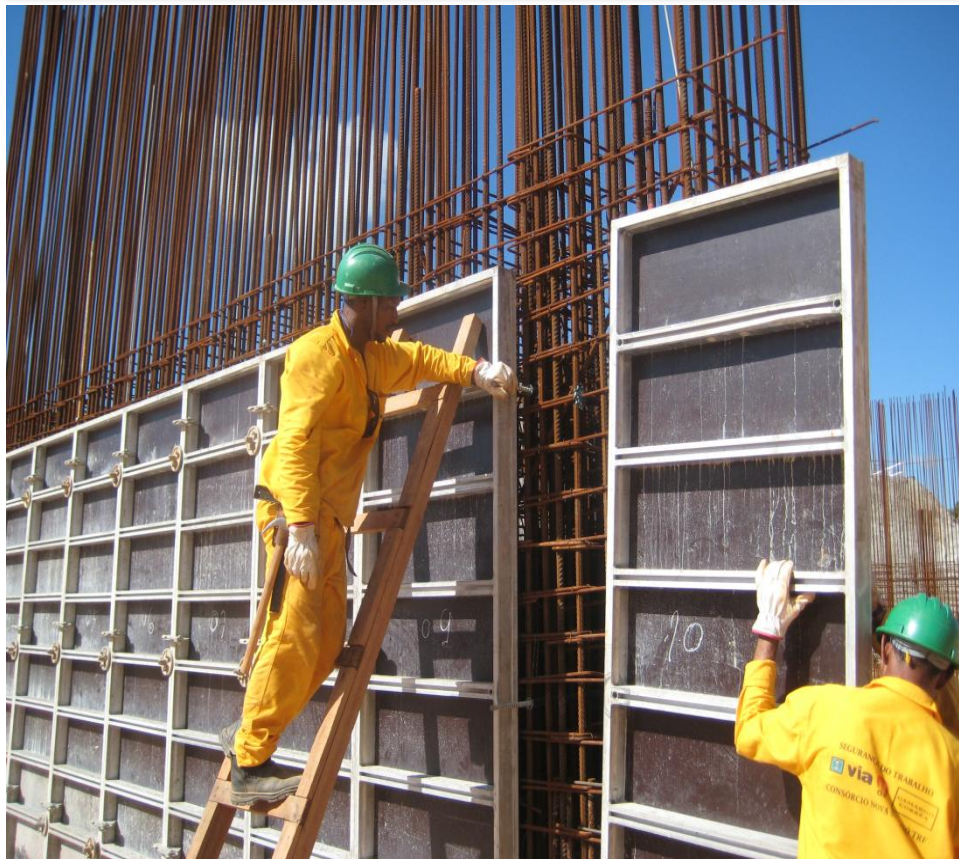
Foto 2-Forma plana Pilares 3º subsolo, trecho V entre os eixos 7 e 13, ref. Item 03.02.110.1.01 no Memorial descritivo
