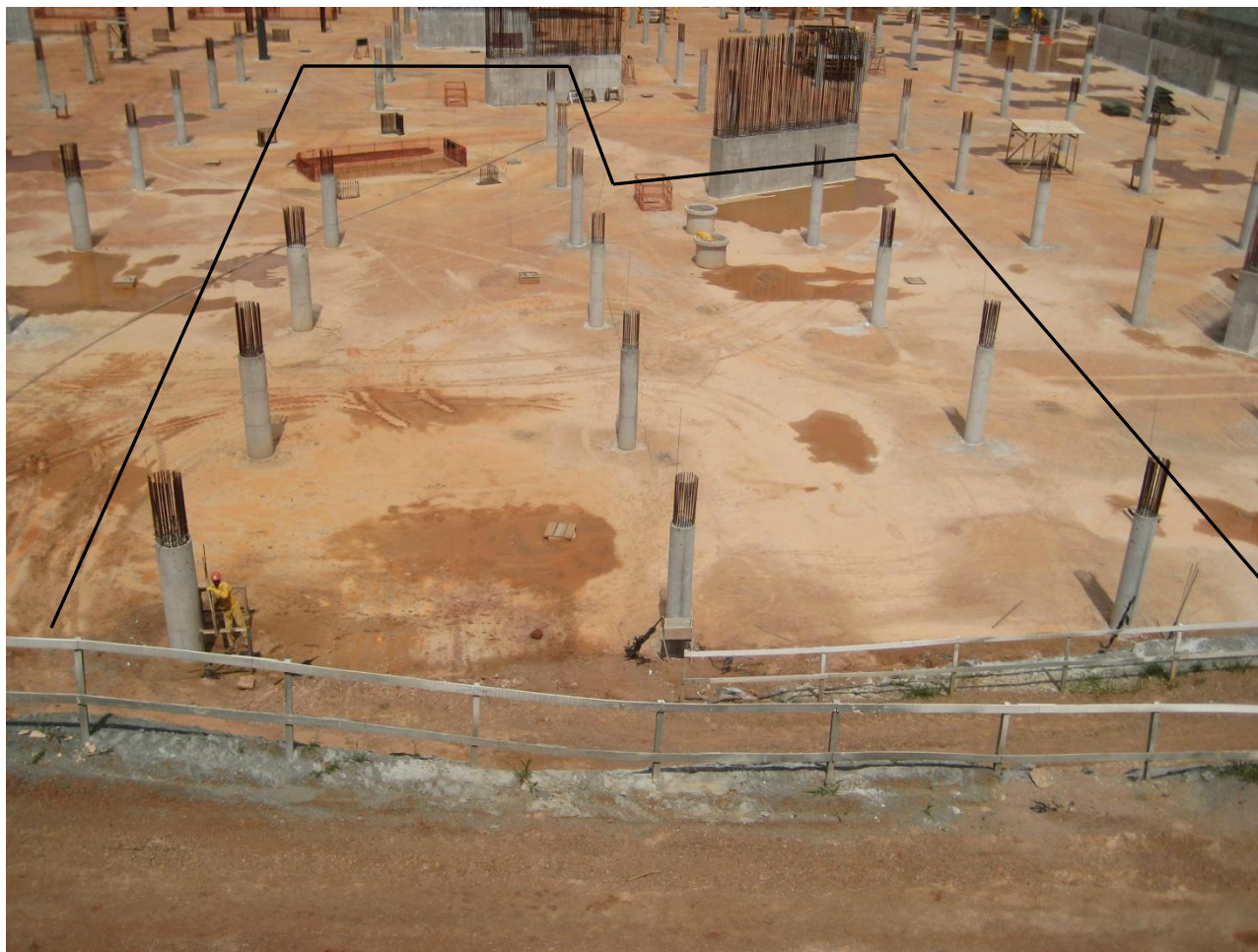
Foto 10 – Concreto pilares circulares trecho I entre os eixos 6 e 8, ref. Item 03.02.700 no Memorial descritivo
